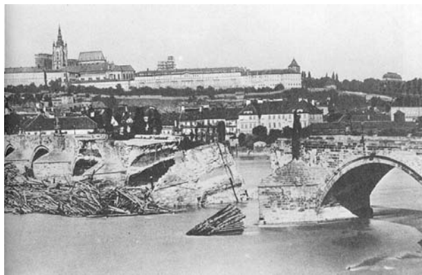
Figure 37 Charles Bridge & 1890 flood damage; Kohout, Technické proměny , 48.
